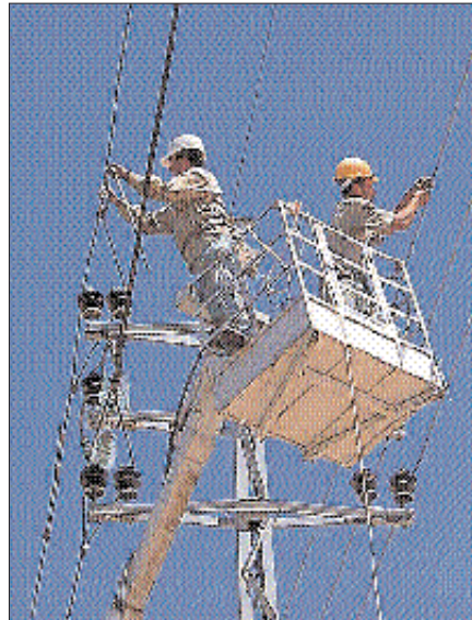
اصلاح الشبكة الكهربائية بطريقة تقنية آمنة
